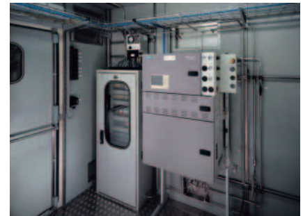
Fig. 10: MAXUM Prozess-GC in a shelter
