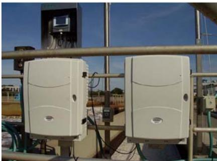
Анализаторы Amtax sc и Phosphax sc, объединенные в одну аналитическую систему
