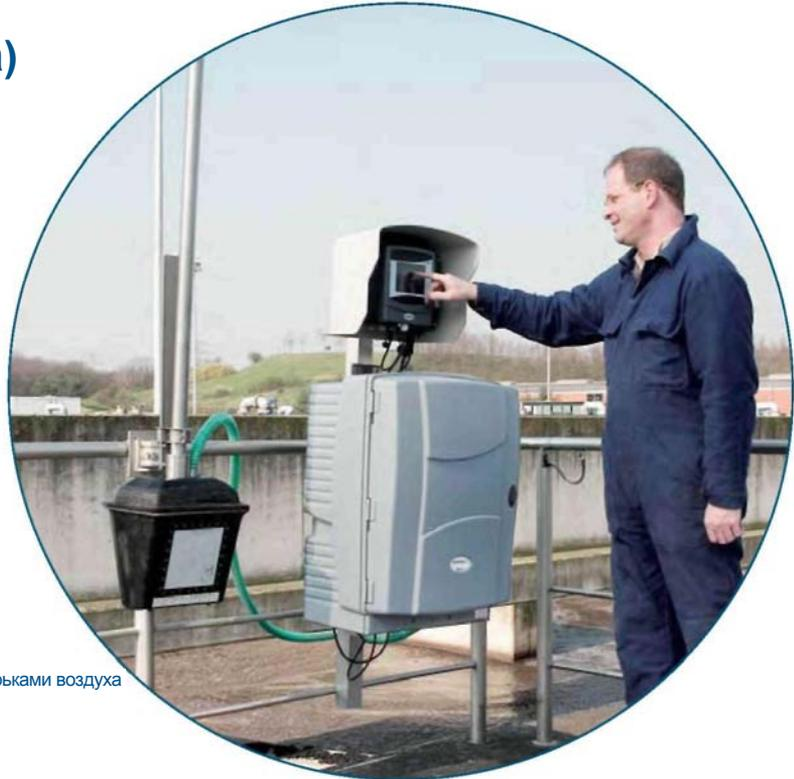
Низкие эксплуатационные расходы: Погружной фильтр-датчик отбирает пробы непрерывно. Воздушные пузырьки предотвращают формирование налета на модуле фильтра.
