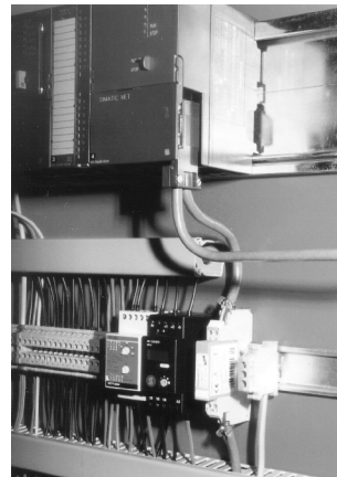
Рисунок В-3 Вторичная защита в шкафу, вблизи первого узла шины
