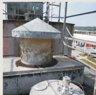
SITRANS LR460 (на заднем плане) и SITRANS LR560 (на переднем плане) измеряют уровень ячменного солода в компании «United Canada Malt Ltd». Компактность уровнемера SITRANS LR560 позволяет легко перенести его на верх силоса.
