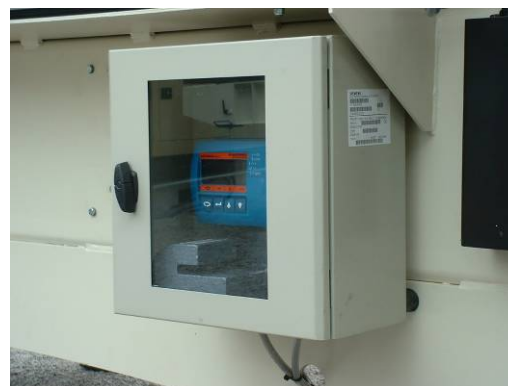
BW-100 в корпусе с защитой от вибрации
