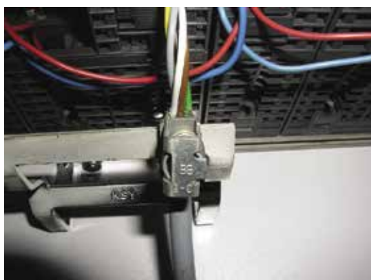
Рис. 6-3. Установка экранированных клемм на модуль (пример)
