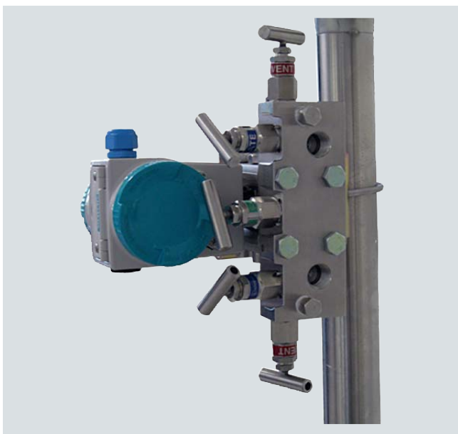
Вентильный блок 7MF9411-5CA на преобразователе SITRANS P500 для измерения дифференциального давления и расхода (включая монтажный кронштейн)
