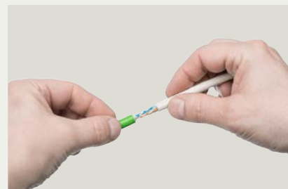
Удалите оплетку и снимите витой экран
