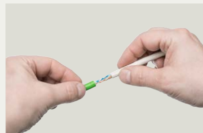
Удалите оплетку и снимите витой экран
